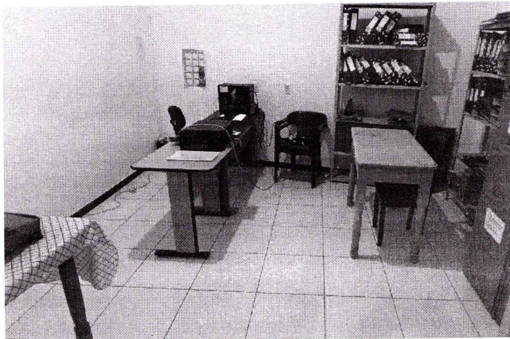
Salas com piso em lajota cerâmica.
